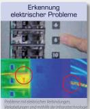
Probleme mit elektrischen Verbindungen, Verkabelungen sind mithilfe der Infrarottechnologie klar als, Hot Spots "zu erkennen. Auf diese Weise können Defekte schnell erkannt und repariert werden. Auf dem Wärmebild sind die überhitzten Anschlüsse deutlich zu erkennen.
